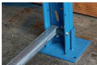
Platine acier à fixer au sol.
